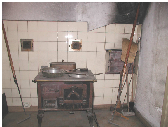
Holzherd in der oberen Küche mit Backofen (rechts)
